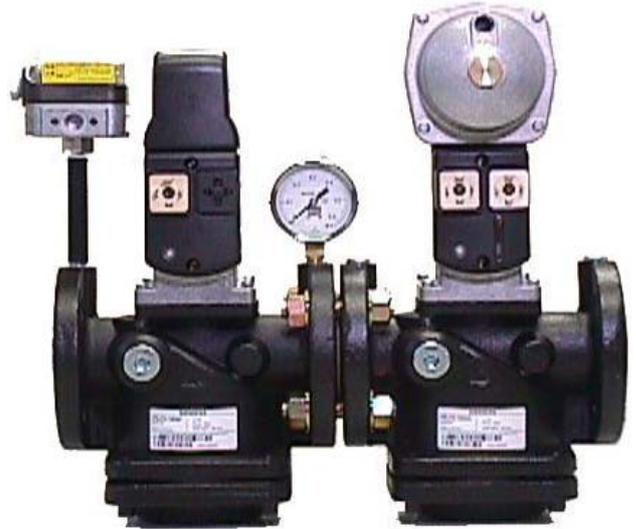
VGU20S / 30Sシステムは全長40cm内に中圧B供給の遮断、整圧(ガバナ)制御及びその他必要な附属装備が効率よく複合化されていますので、コストダウンを容易にします。
